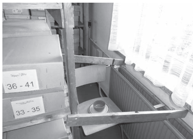
Abenteuerlich abgestützte Regalkonstruktionen und ein Entlüftungsventil für die Heizung neben den Archivschachteln. Sicherheit und Arbeitsschutz spielten hier keine Rolle.
